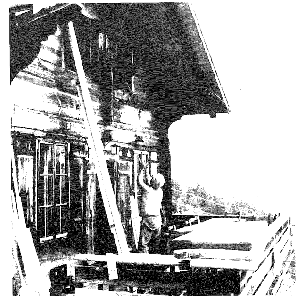
Die Aussenrenovation wird in Angriff genommen
